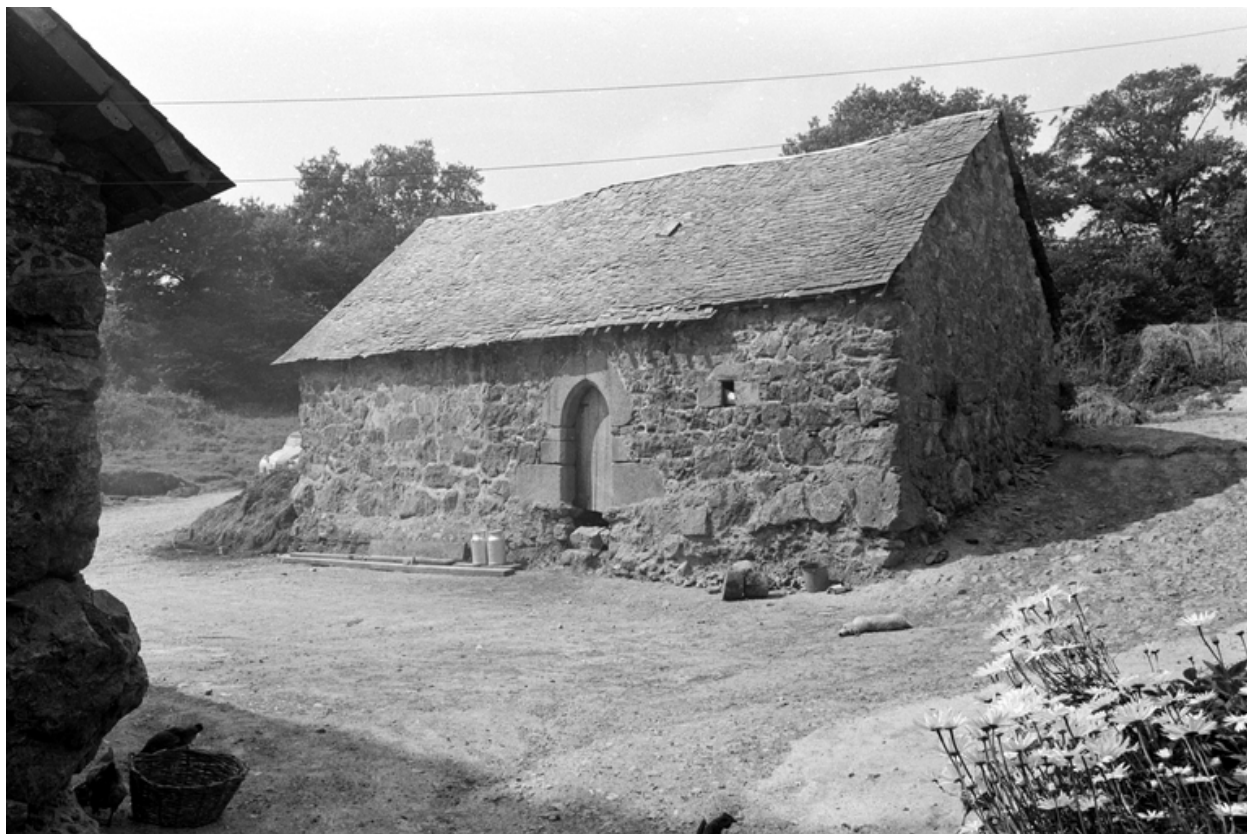
Vue de la façade antérieure du commun est
