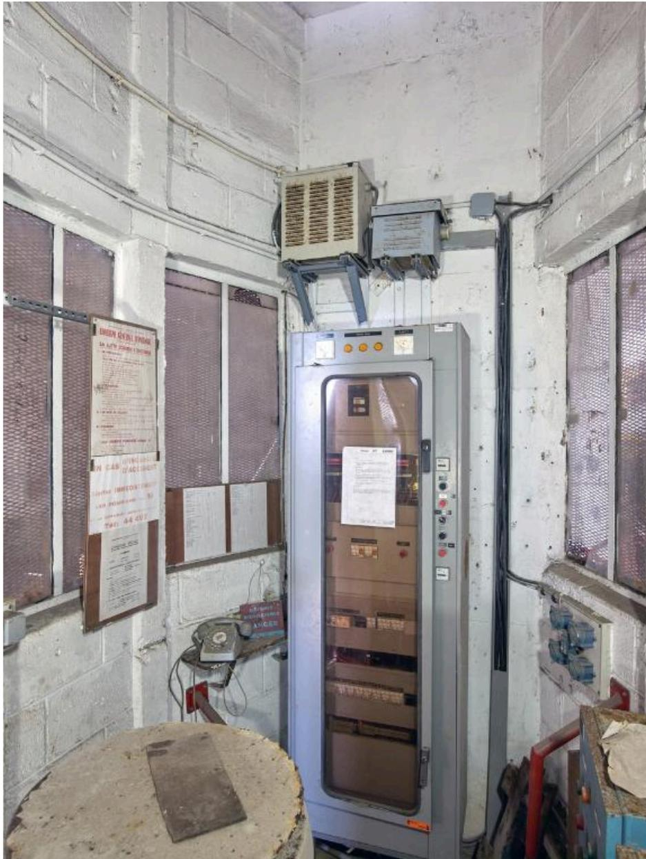
Vue du local des pompes nord situé entre les alvéoles A et B : tableau électrique des pompes 1 et 2, notice de mise en route et d'entretien, consigne générale d'incendie, liste des numéros et poste téléphonique
