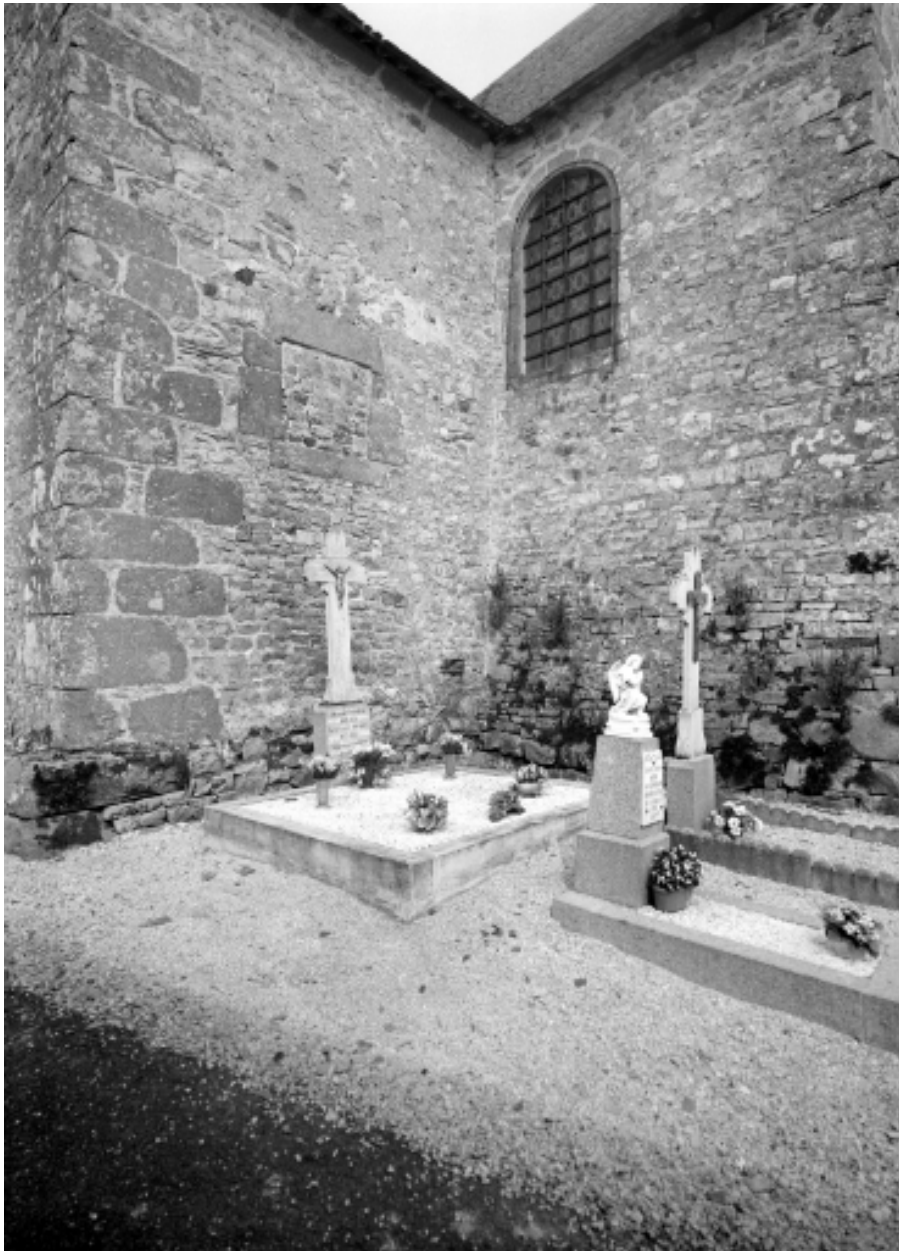
Elévation sud, angle mur est de la sacristie et mur sud du choeur : vue générale
