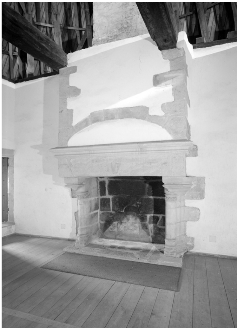
Tour sud-ouest, troisième niveau, cheminée, vue générale.
