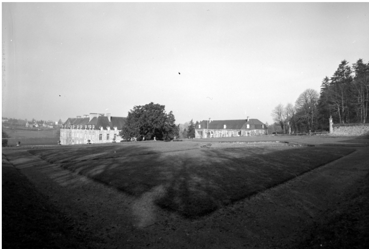
Vue de situation sud est
