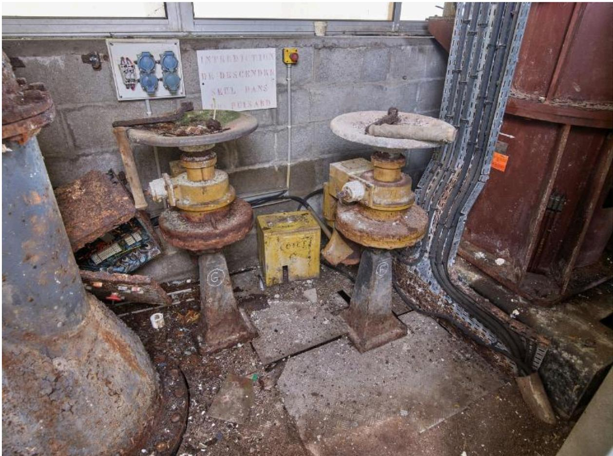
Vue des commandes à volant des pompes des bassins G et F. Deux manivelles sont posées sur les volants
