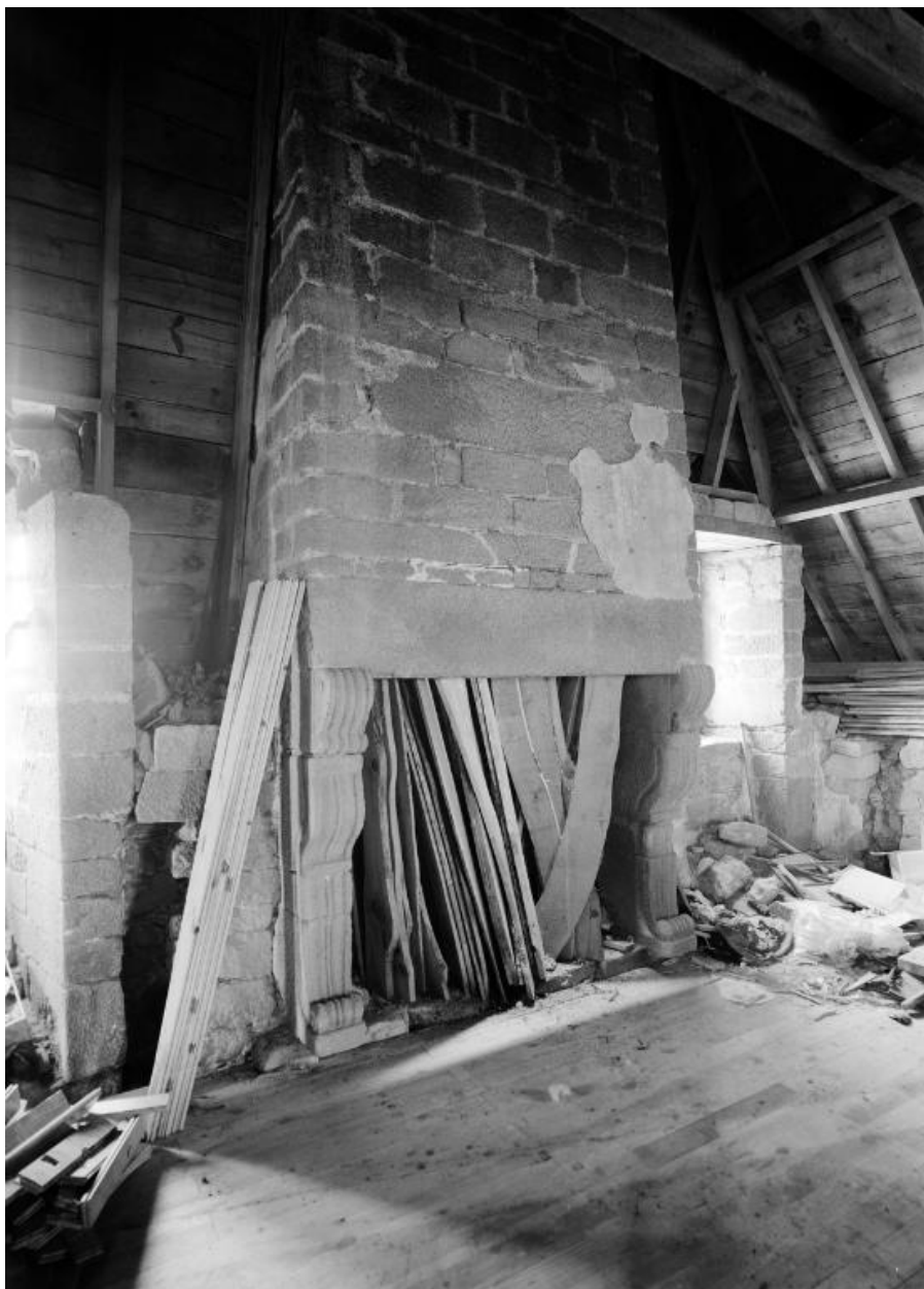
Cheminée du grenier contre le mur ouest
