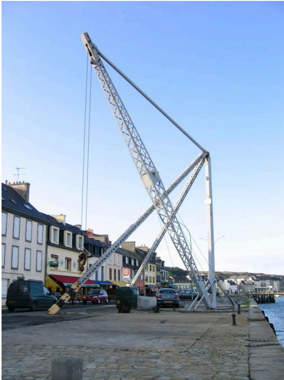
Grue à mâter et de levage sur le quai Toudouze
