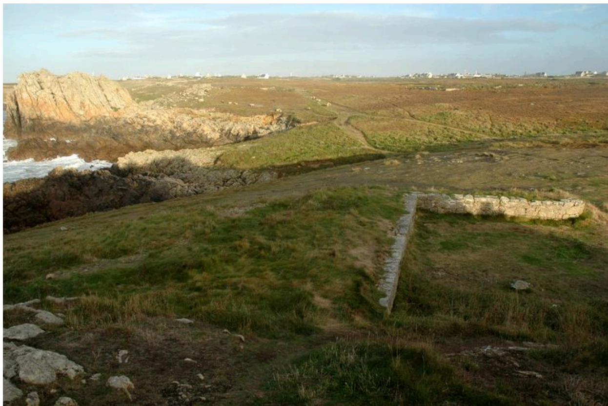
Vue générale : parapet en terre avec mur de genouillère en maçonnerie
