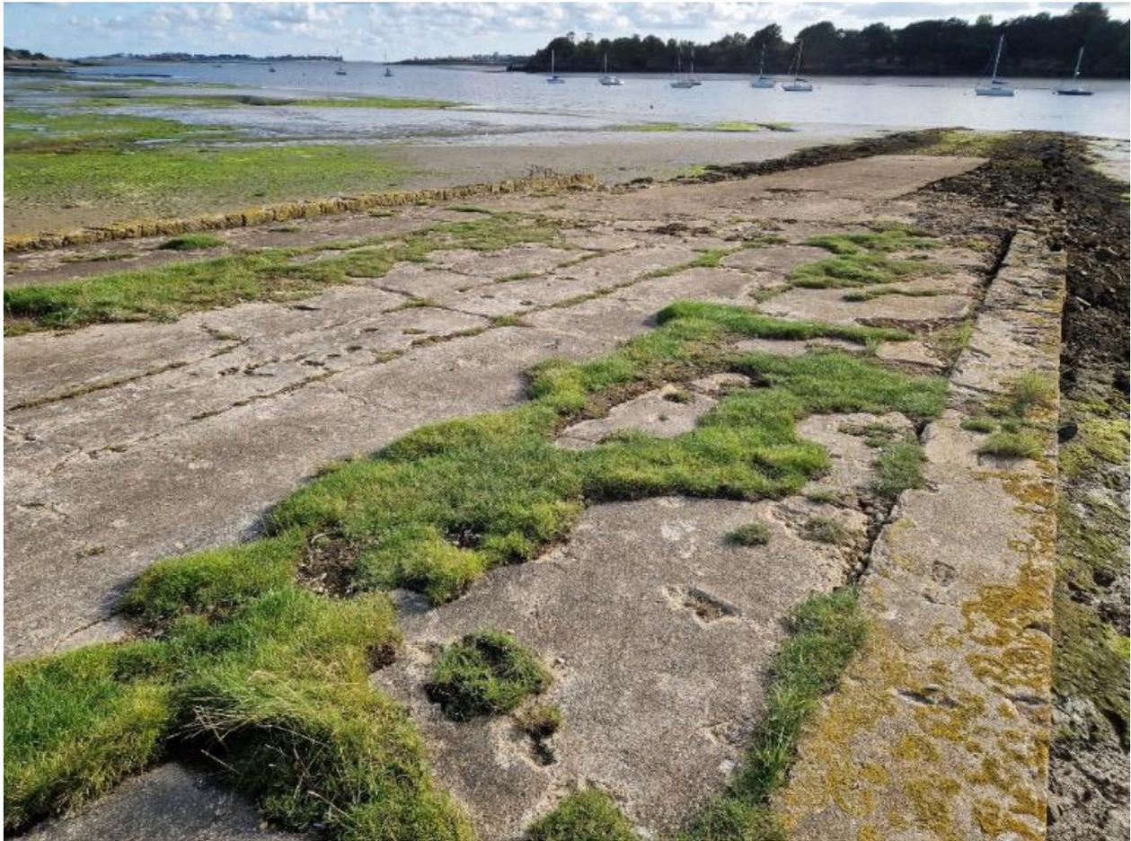
Vue générale du slipway vers la Penzé : dégradation et végétalisation spontanée de la partie supérieure en béton armé
