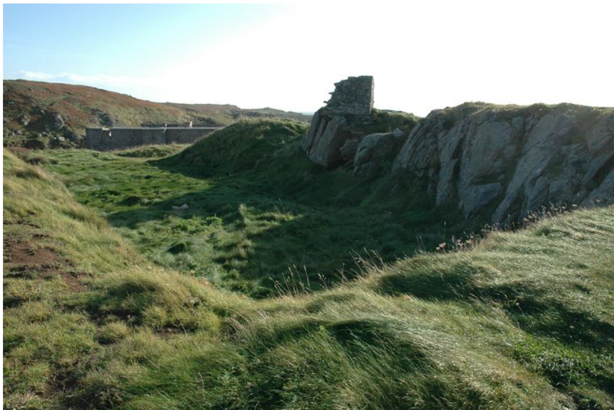
Vue générale de la batterie haute
