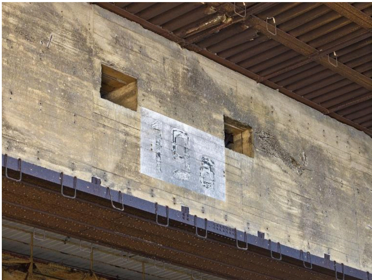
Vue de l'entrée de l'alcôve : numérotation 19a sur le linteau (bassin abritant les emplacements 19, 19a et 20)
