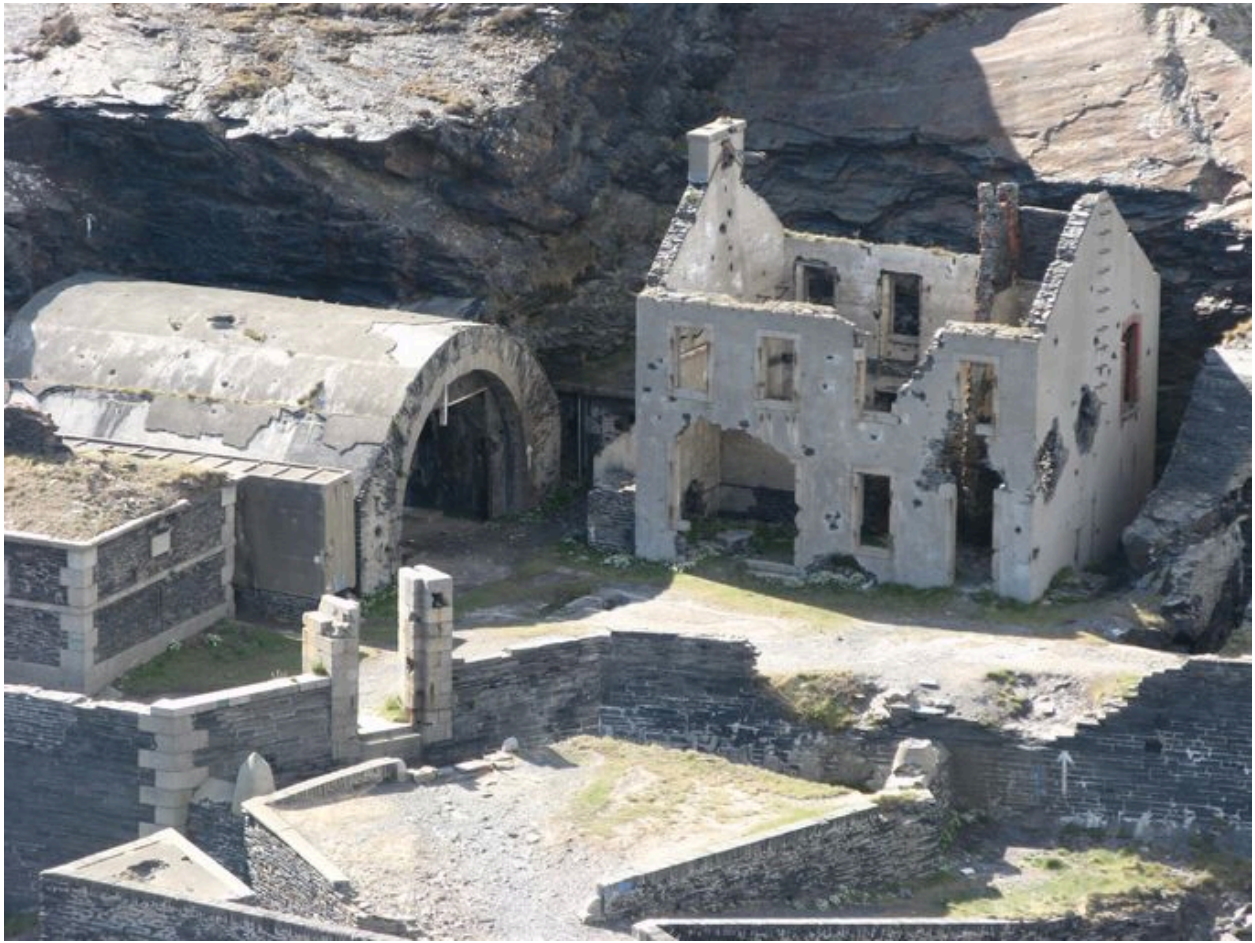
Usine électrique voutée et maison du gardien de l'îlot des Capucins
