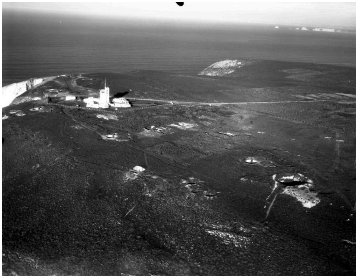
Vue aérienne oblique du Cap de la Chèvre en 1971 : sémaphore, cuves à canon de la batterie d'artillerie française, fouilles d'ouvrages allemands restés inachevés et cratères
