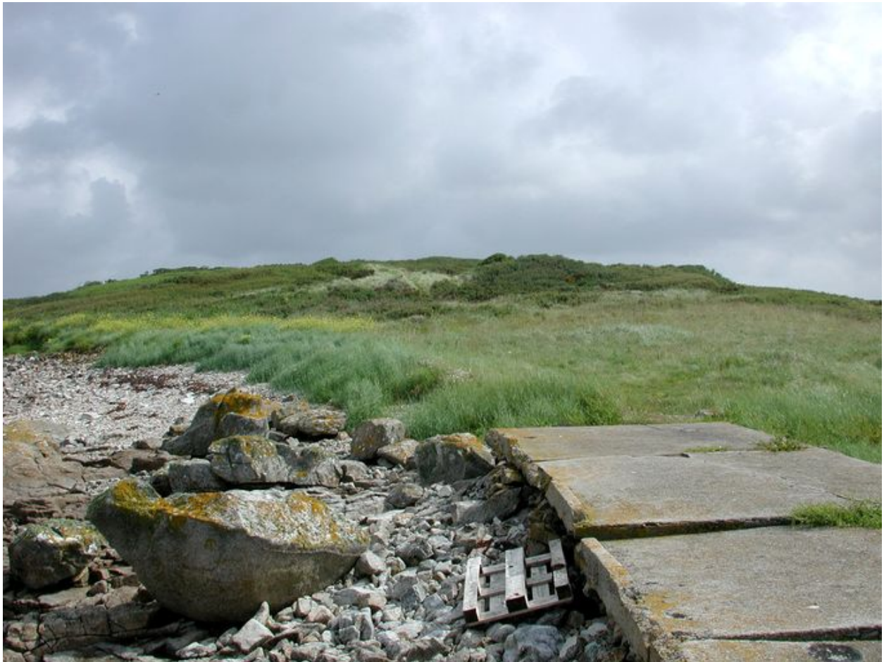
Vue de la cale (état en 2002). Elle est disloquée
