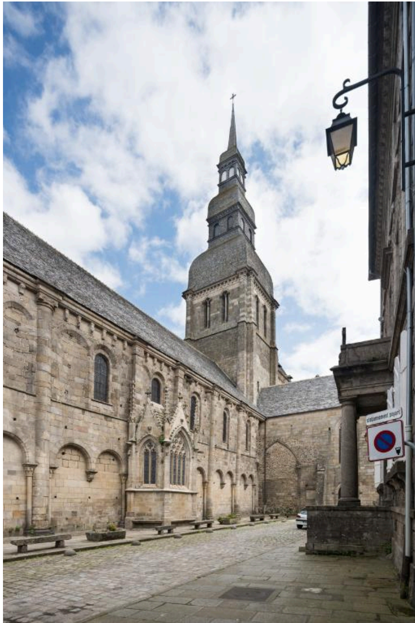
Vue du mur sud de la nef et du clocher de croisée en 2019
