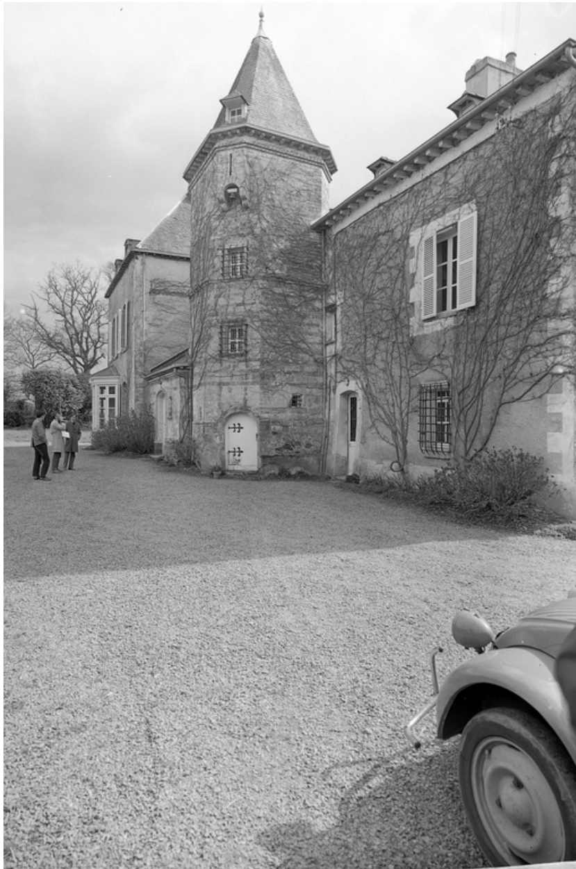
Vue générale de la tour.
