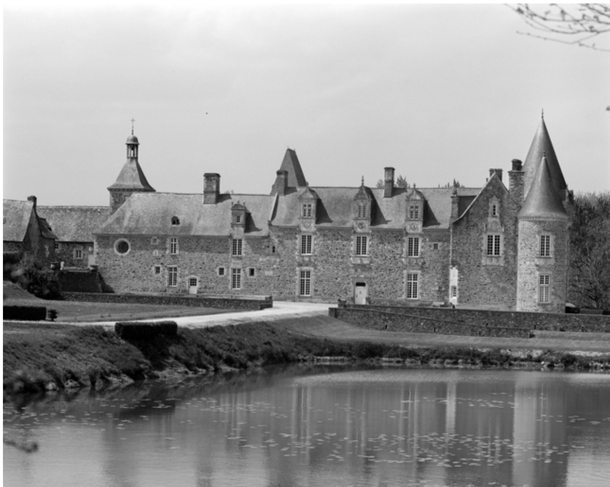
Vue générale de l'élévation sud.
