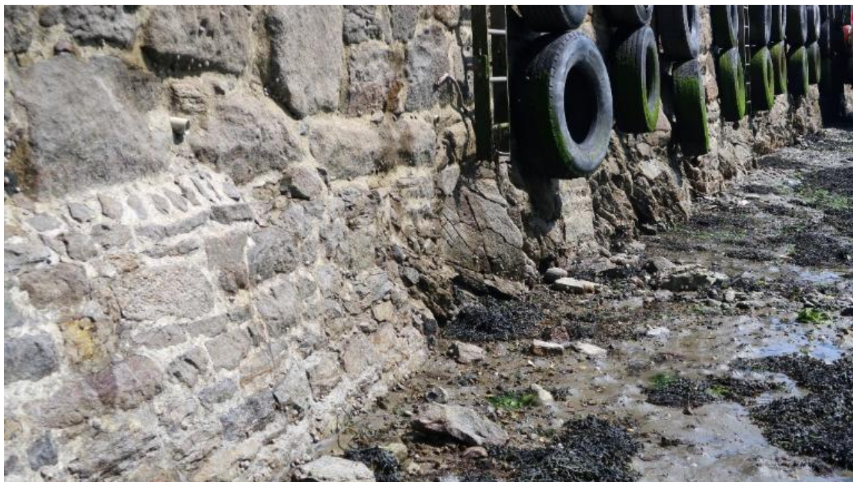
Le vieux quai du port fondé sur rocher : maçonnerie du mur de soutènement sud
