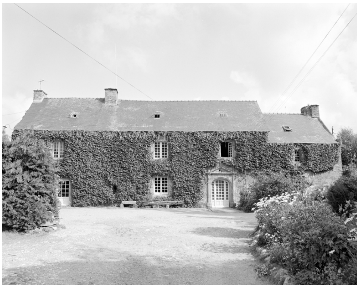
Elévation sud : vue générale
