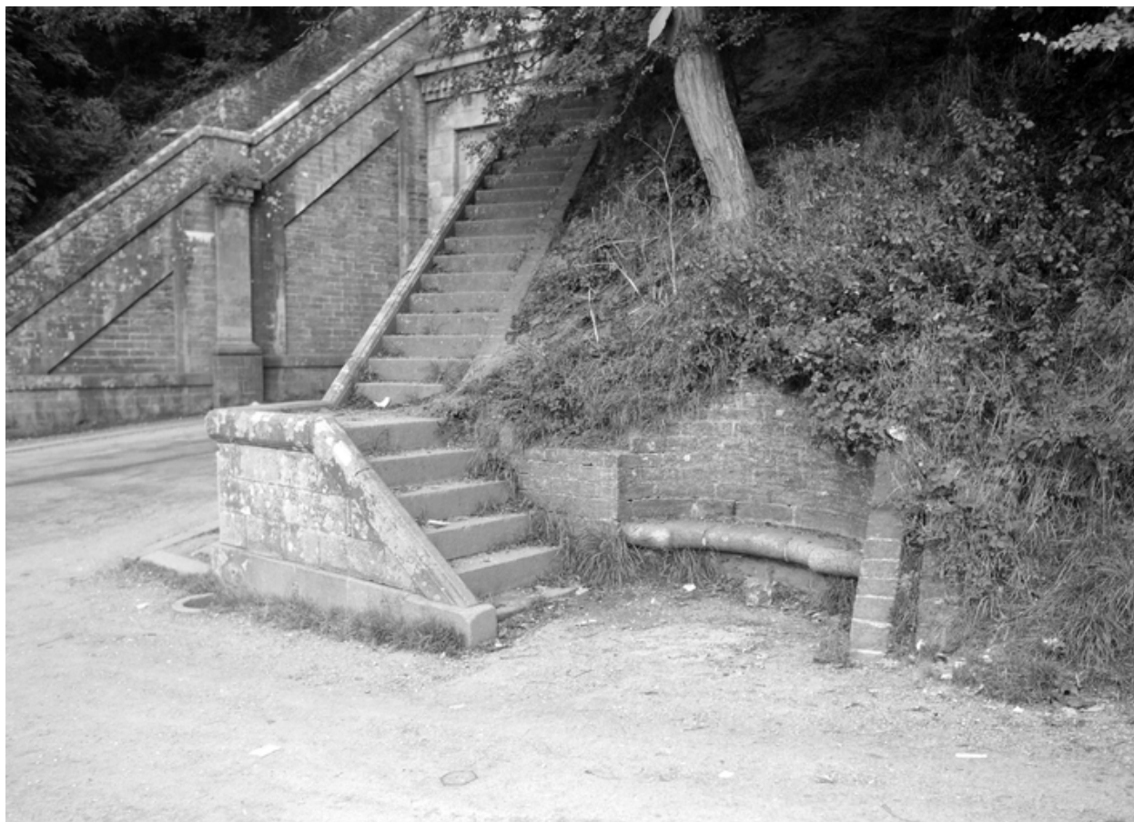
Enceinte de ville - Mur d'enceinte, porte Vauban, détail du banc et départ de l'escalier
