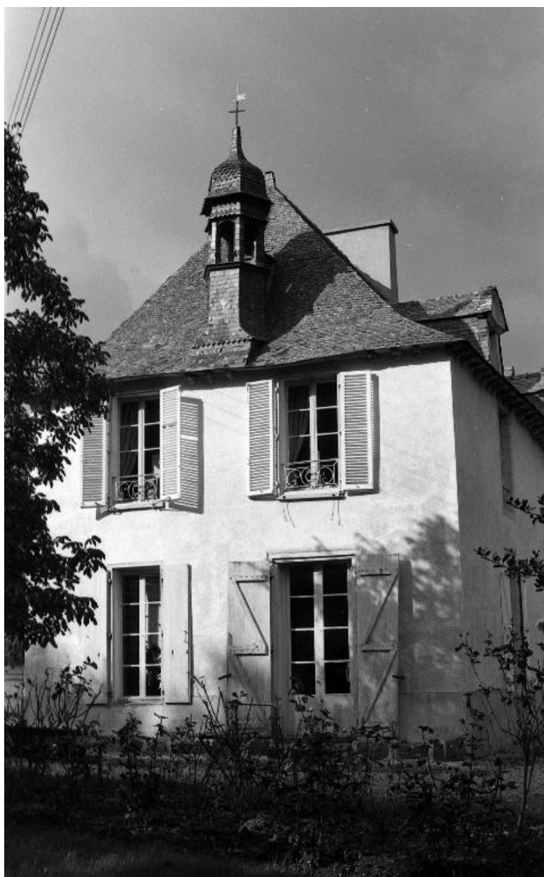
Façade sud : vue générale en 1974
