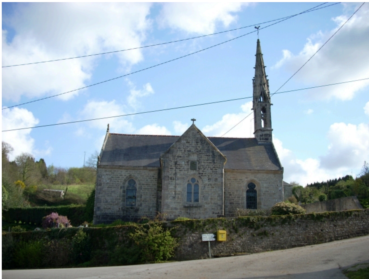
Chapelle Saint-Guénoùlé : élévation nord
