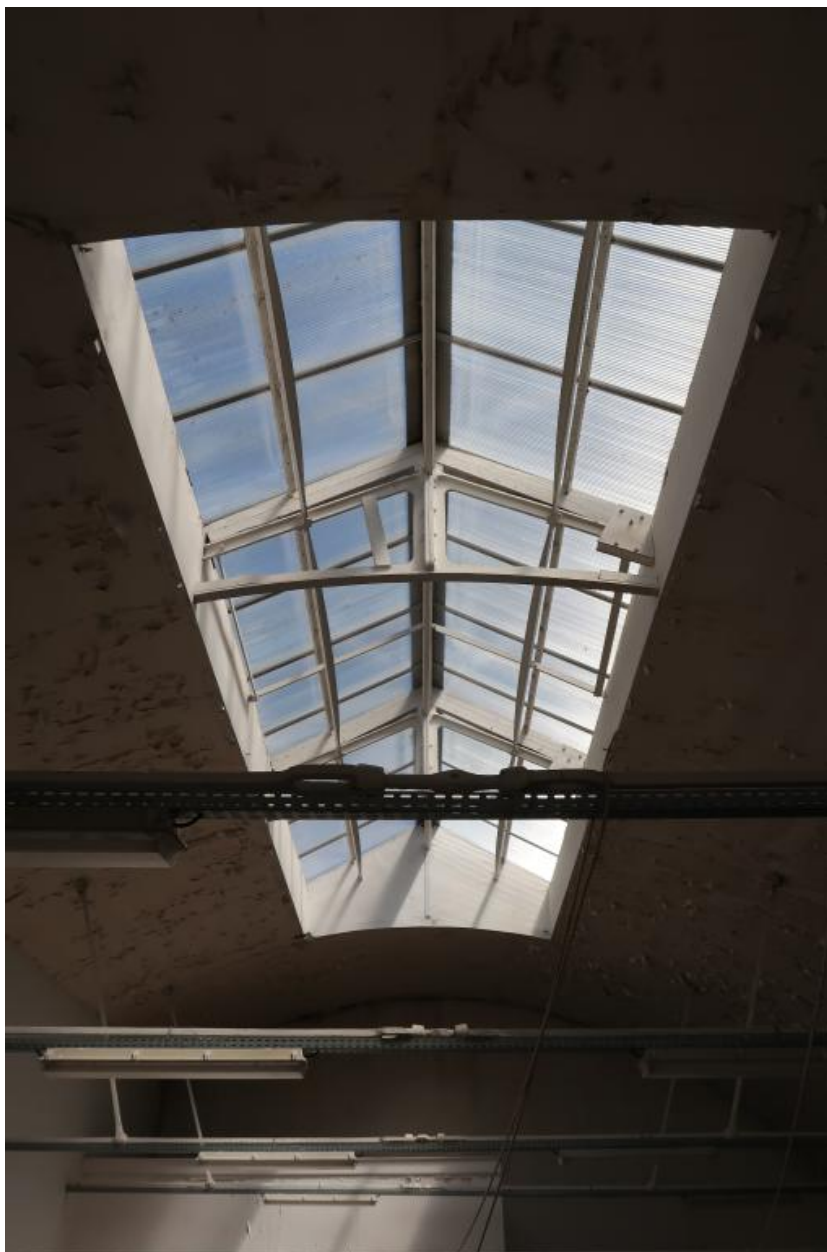
Vue intérieure : partie ouest, charpente métallique et lanterneau (état en 2022)
