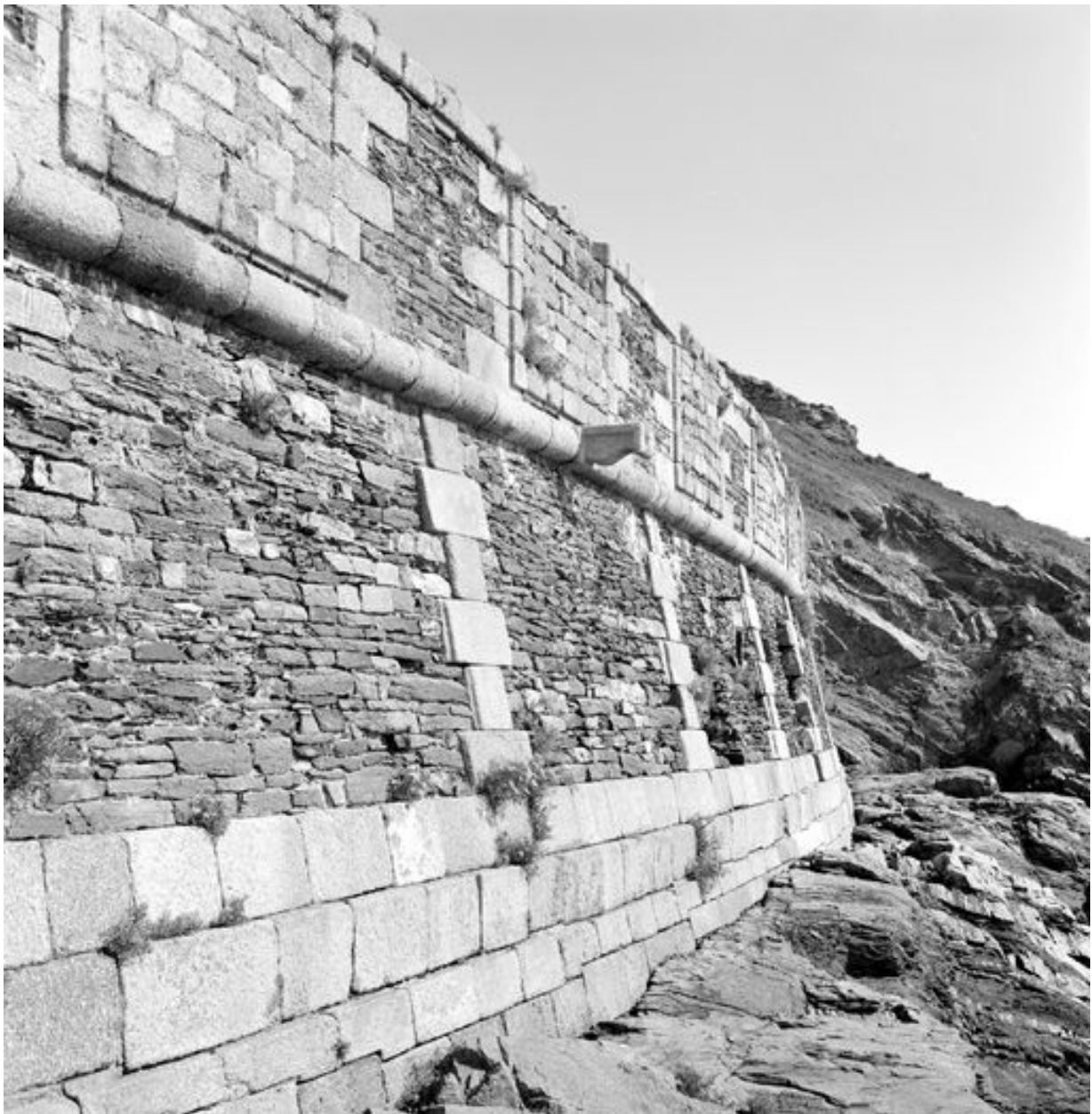
Vue de la batterie de Cornouaille en 1969 : escarpe, chaînes harpées en pierres de taille de granite
