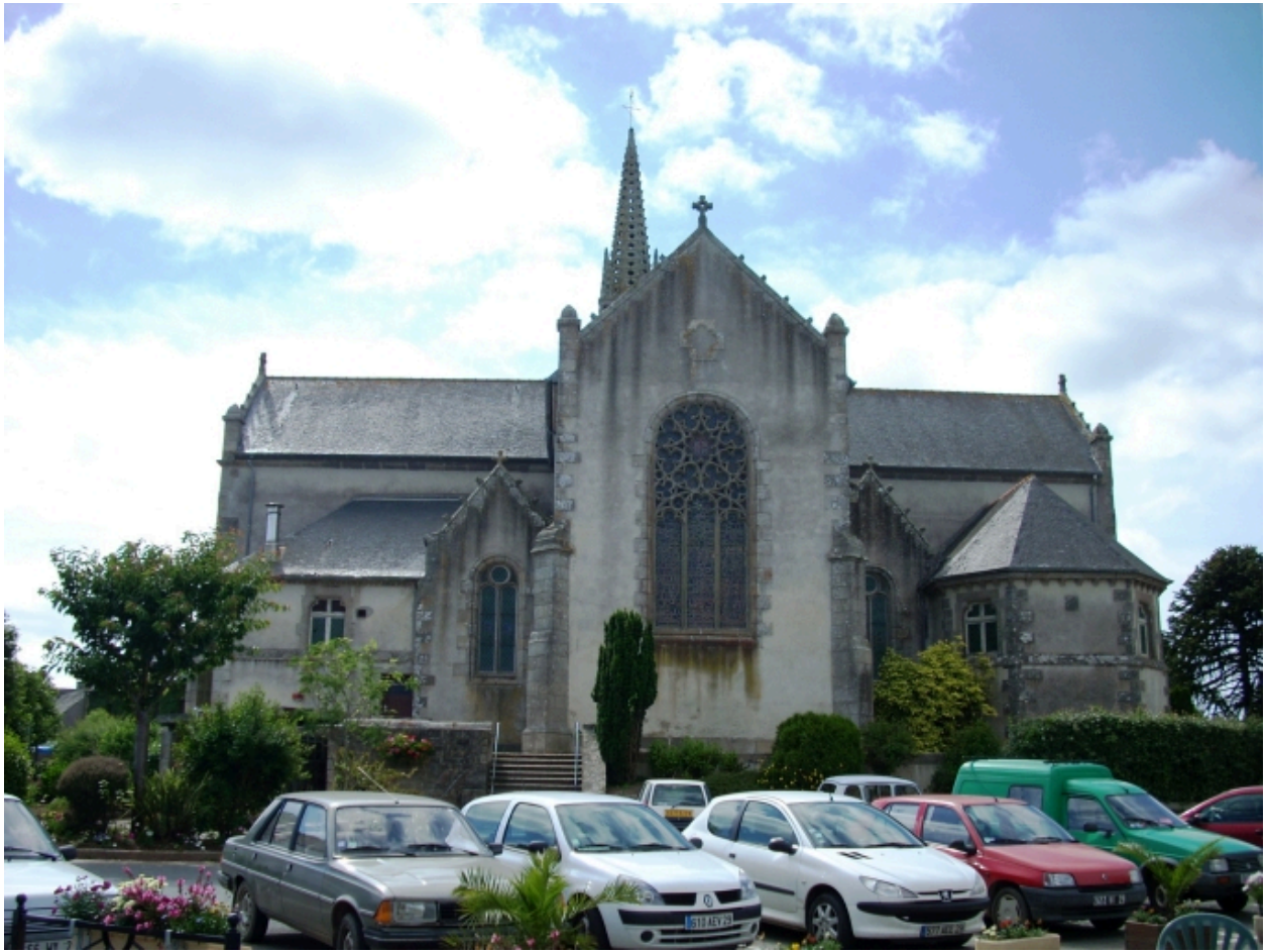
Église : chevet vu de l'est (état en 2008)
