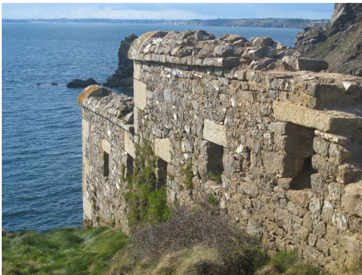
Enceinte du fort de la Fraternité
