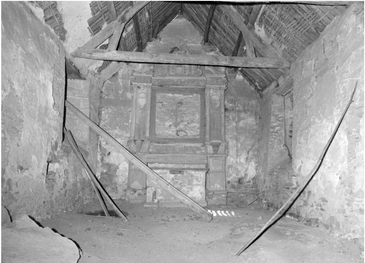
Vue intérieure vers sud-ouest.
