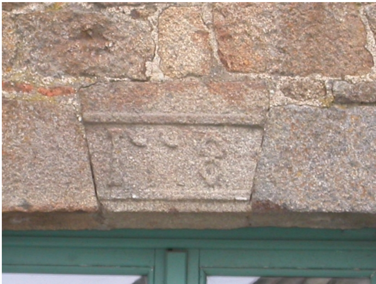
Détail de la date
