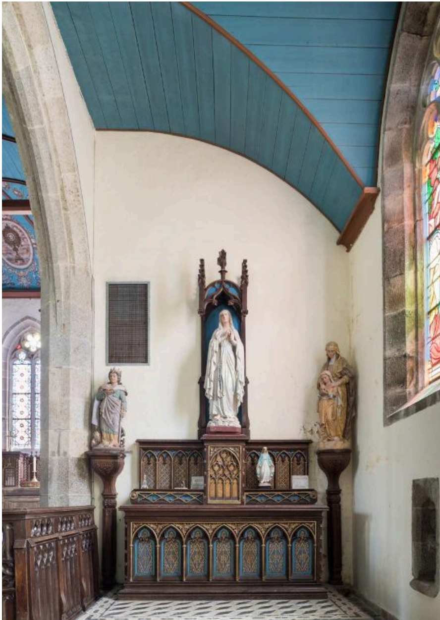
Vue du mur est du bras du transept sud
