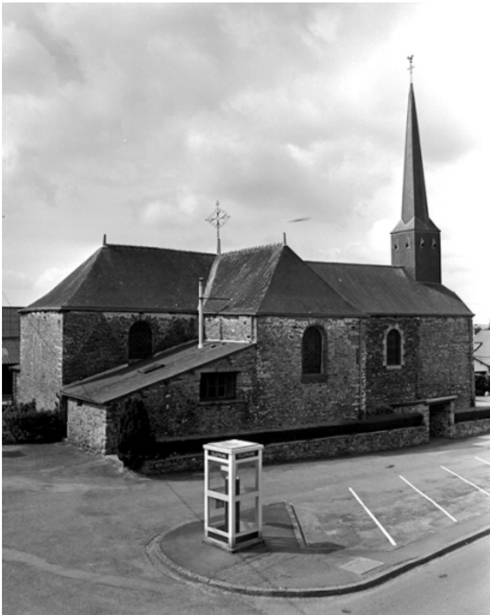
Vue générale nord-est
