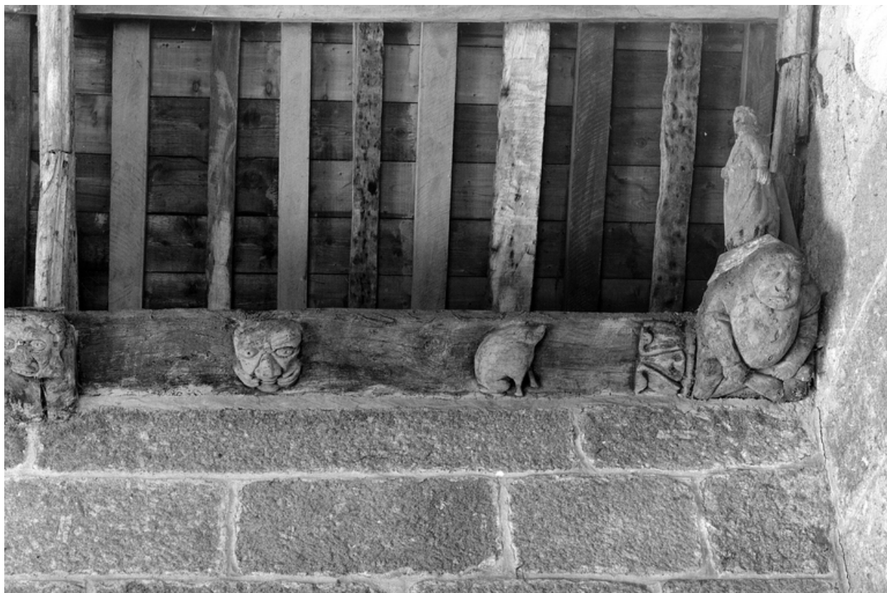
Intérieur, mur nord : sablière, motif III à l'est
