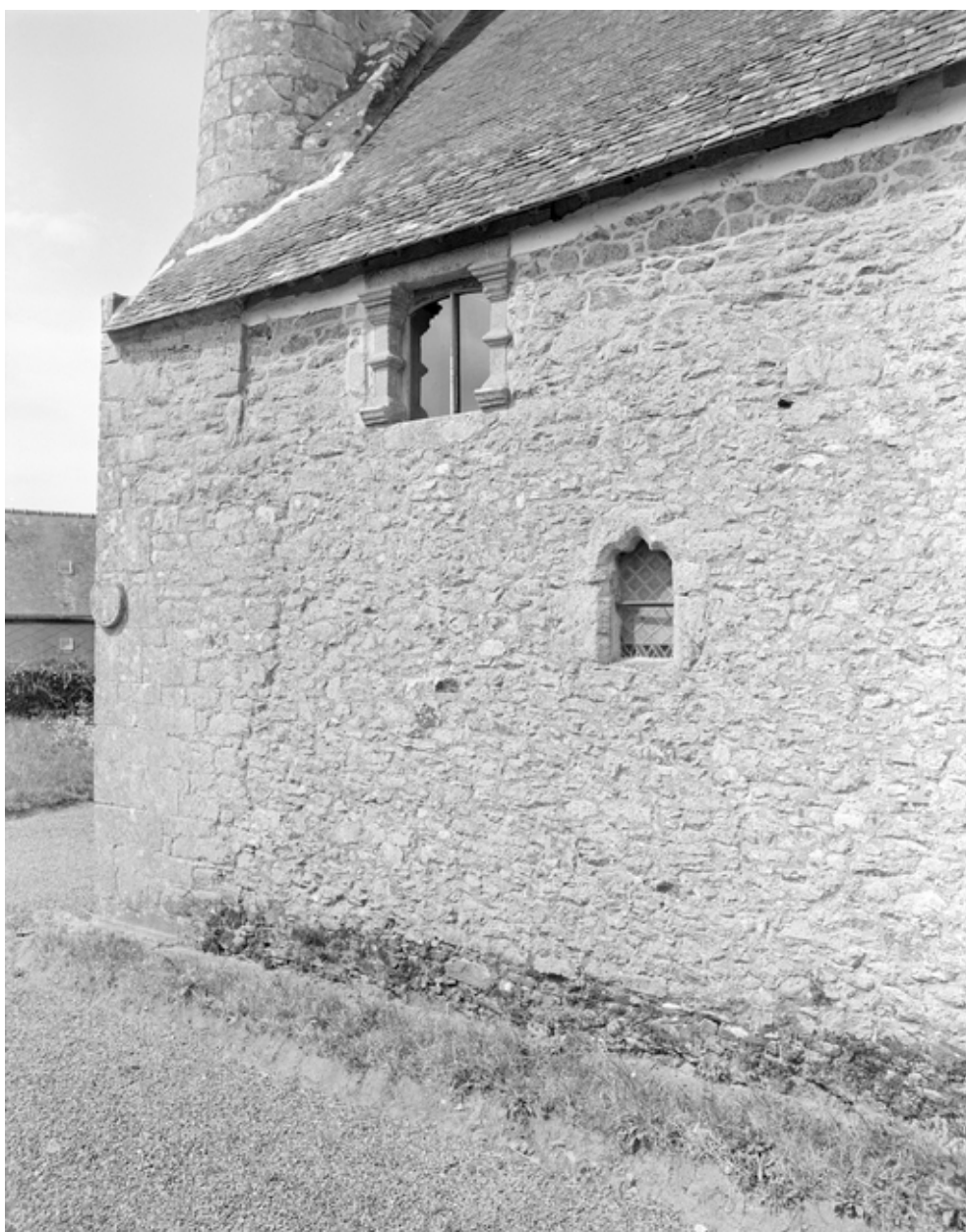
Elévation sud : première et deuxième fenêtres
