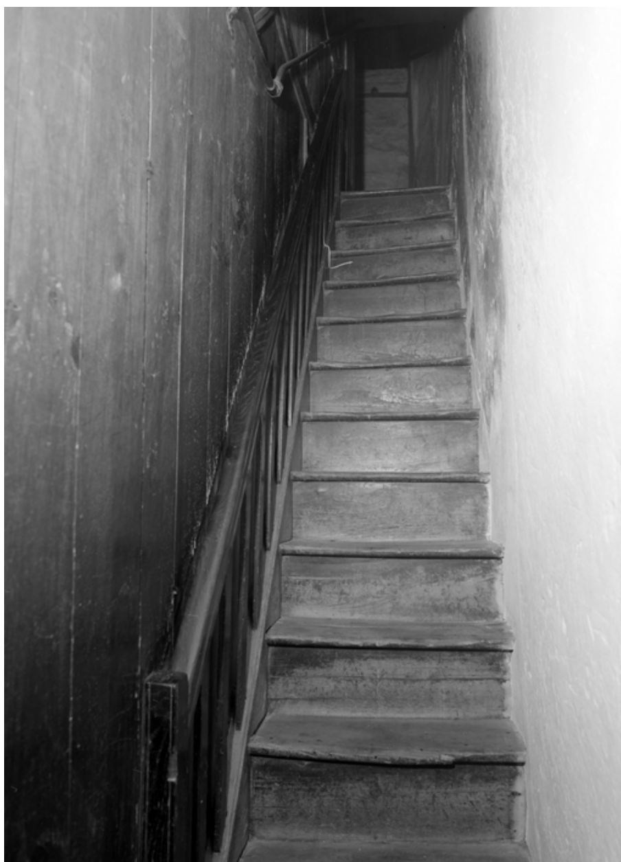
10 rue du fil, escalier, détail.
