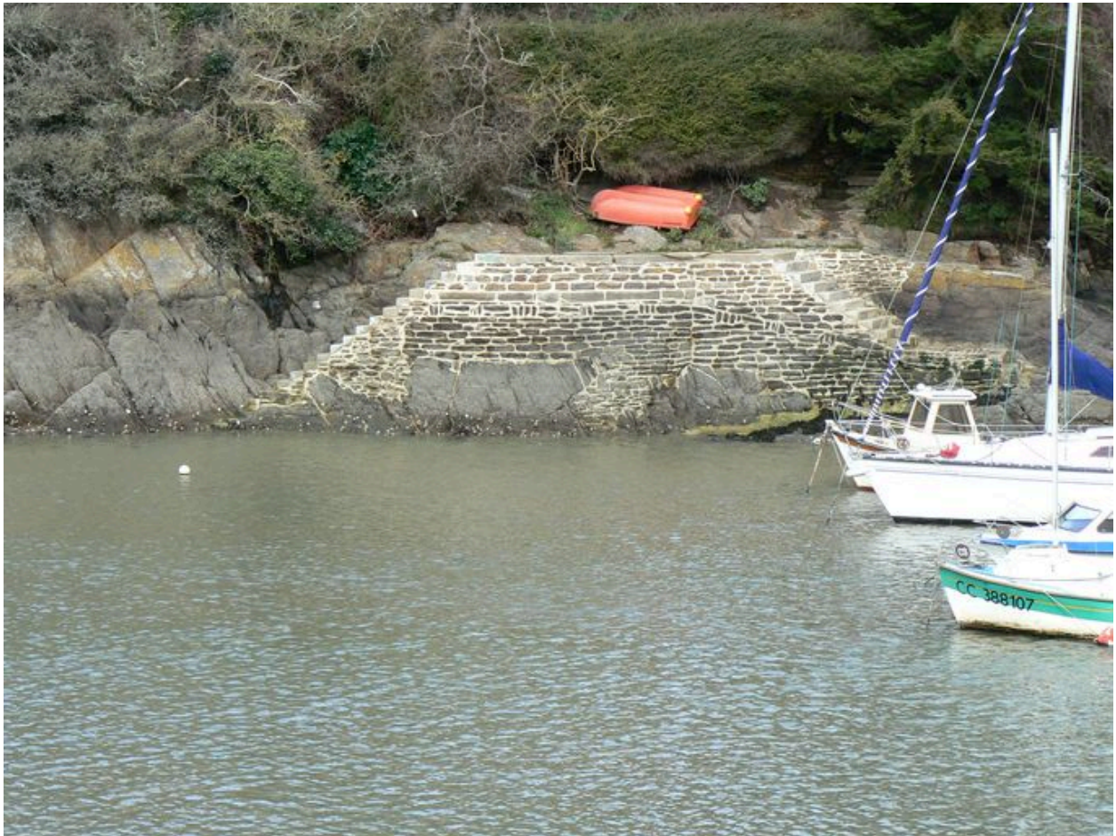
Vue générale de l'appontement pour accéder au feu amont
