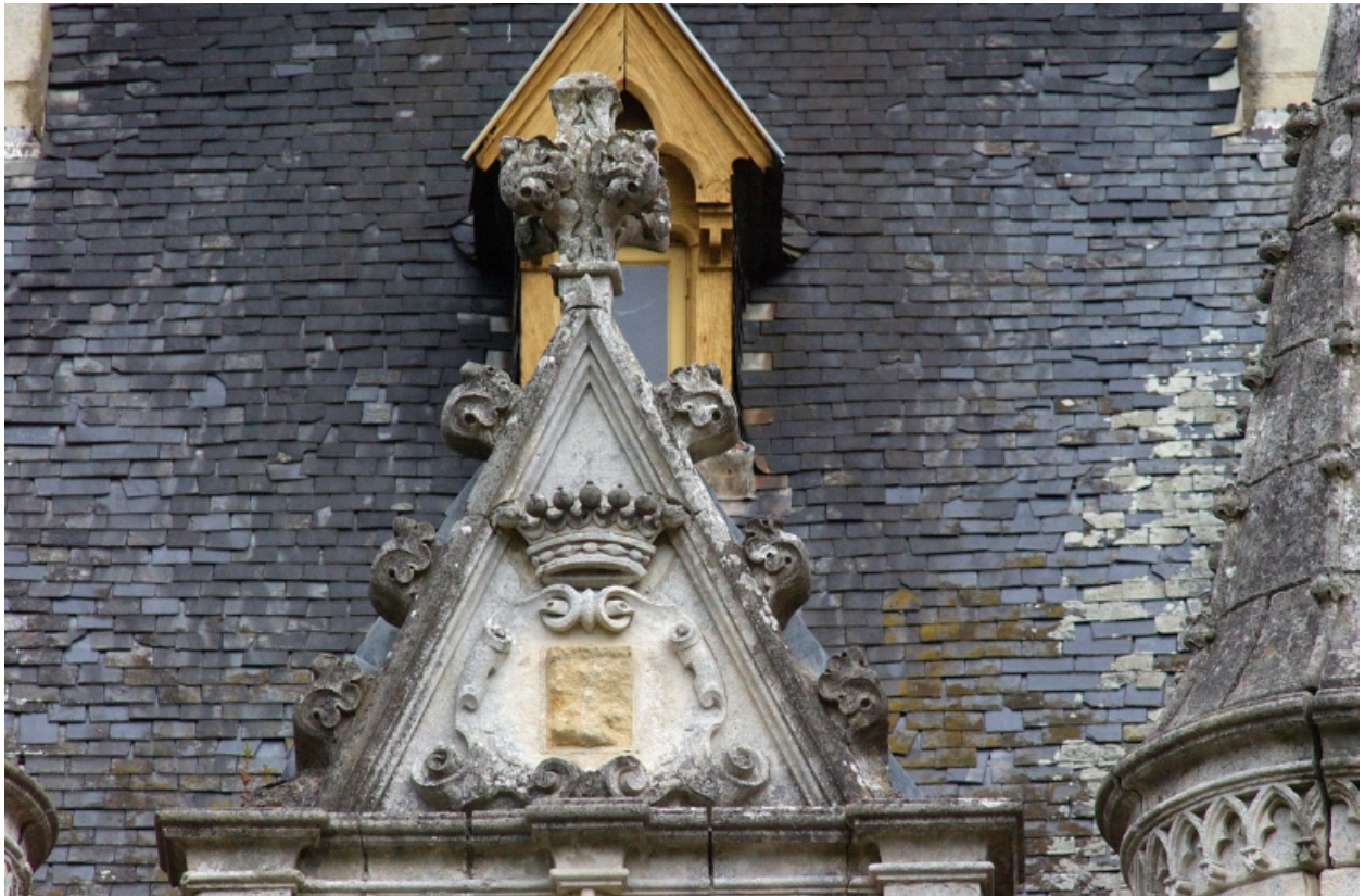
Détail d'une lucarne
