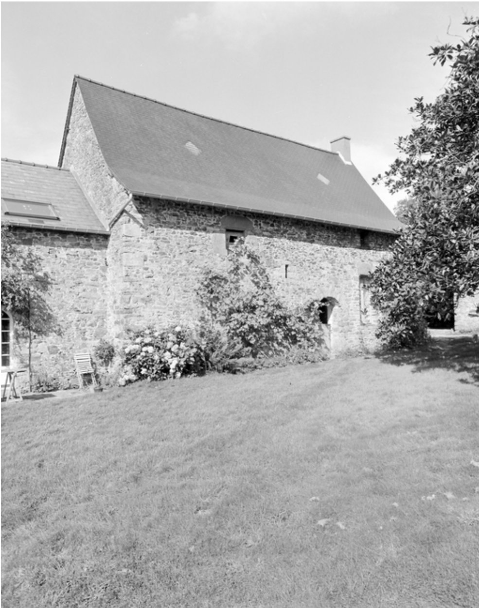
Ancienne étable, élévation est.
