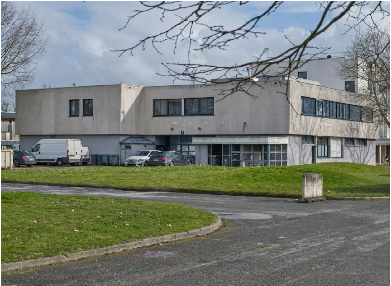
Service de restauration, vue d'ensemble prise du nord-ouest.
