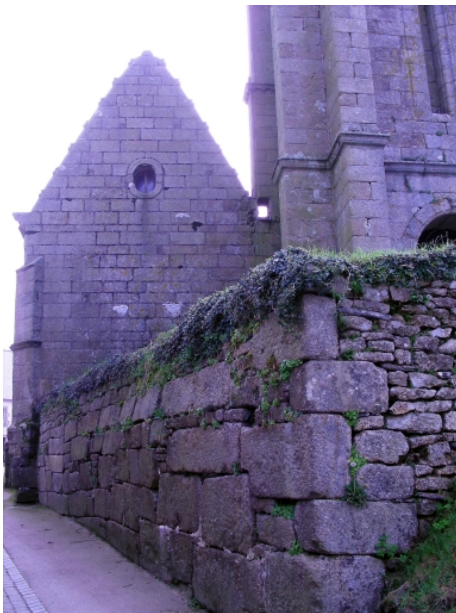
Mur nord-ouest de l'enclos et pignon ouest du bas-côté nord
