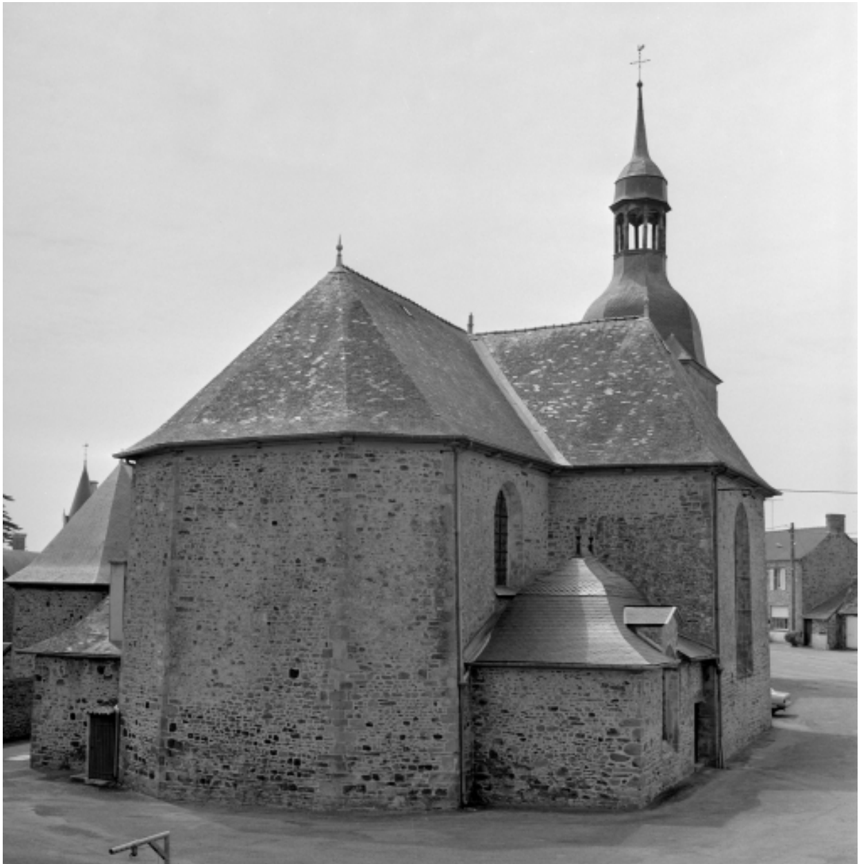
Elévation nord-est : vue générale
