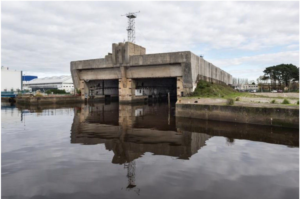
Vue générale du front ouest orienté vers le Scorff. Un pylône surmonte la base
