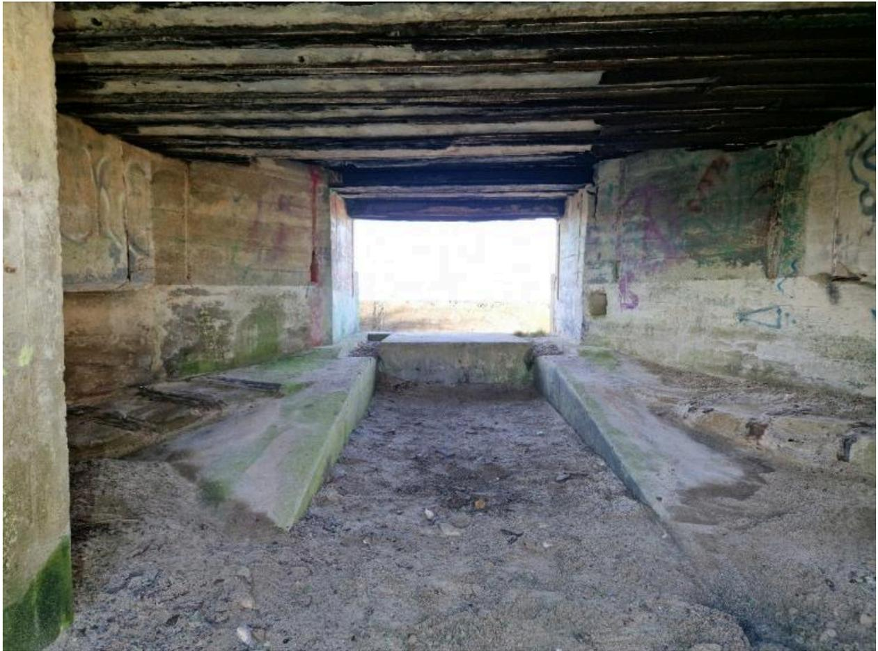
Vue intérieure du bunker-casemate : chambre de combat depuis l'entrée est. Rampes inclinées et rainures permettaient de faire monter puis de caler les roues de l'affût du canon
