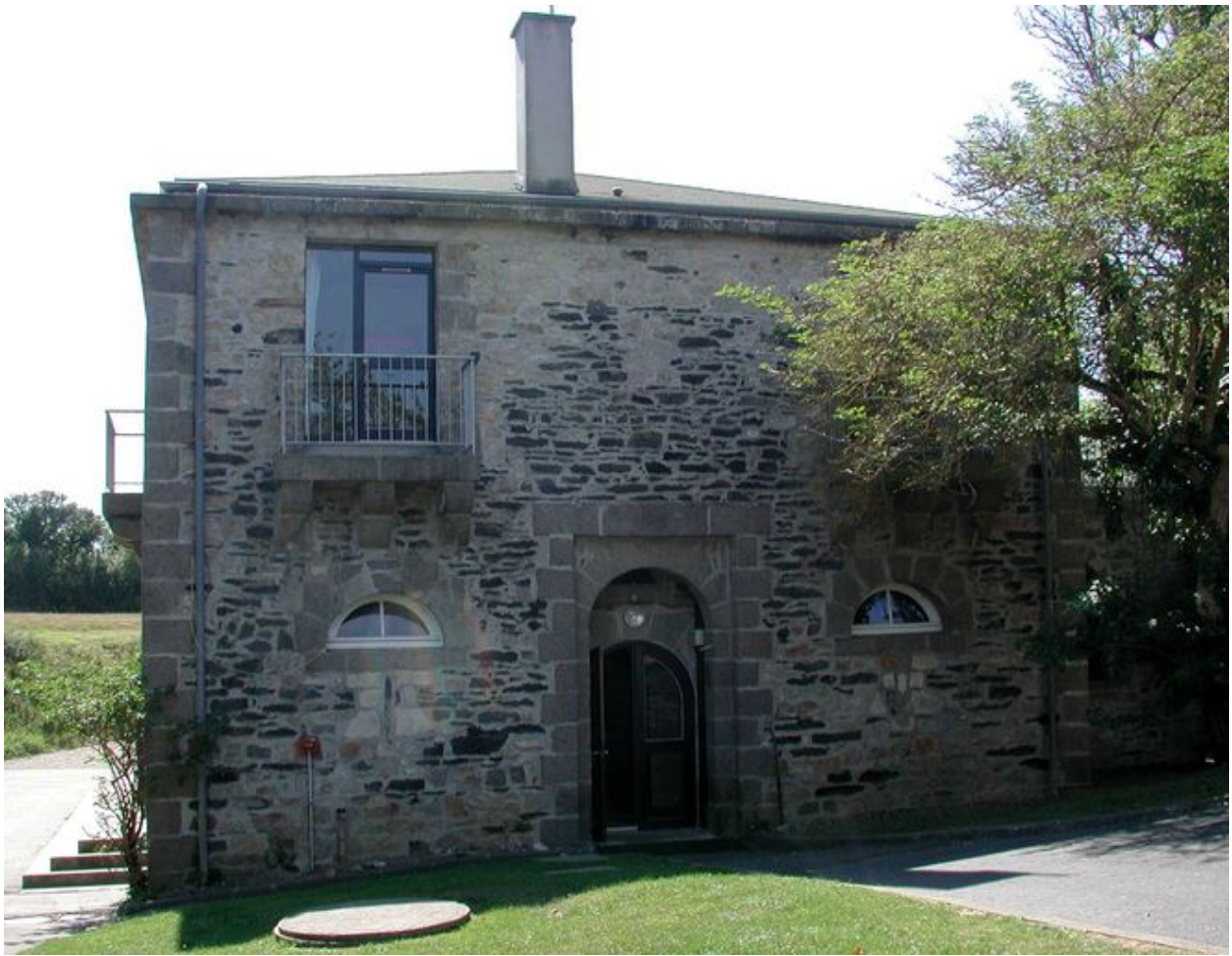
Vue du réduit de batterie de côte de Postolonnec aujourd'hui transformé en centre de colonies de vacances
