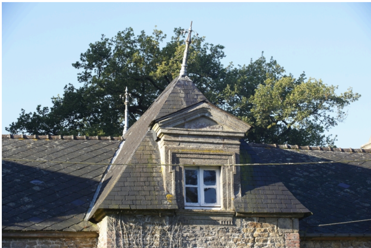
Détail de l'une des lucarnes des communs
