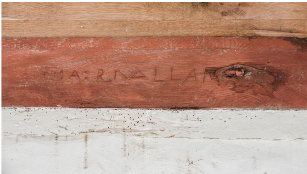
Vue de détail : inscription sur la sablière nord
