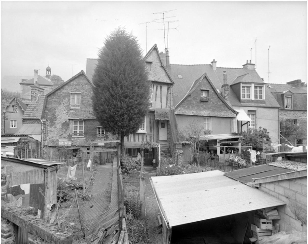
Vue générale de l'élévation postérieure.
