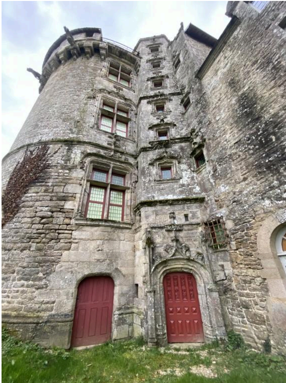
Tour d'escalier, détail
