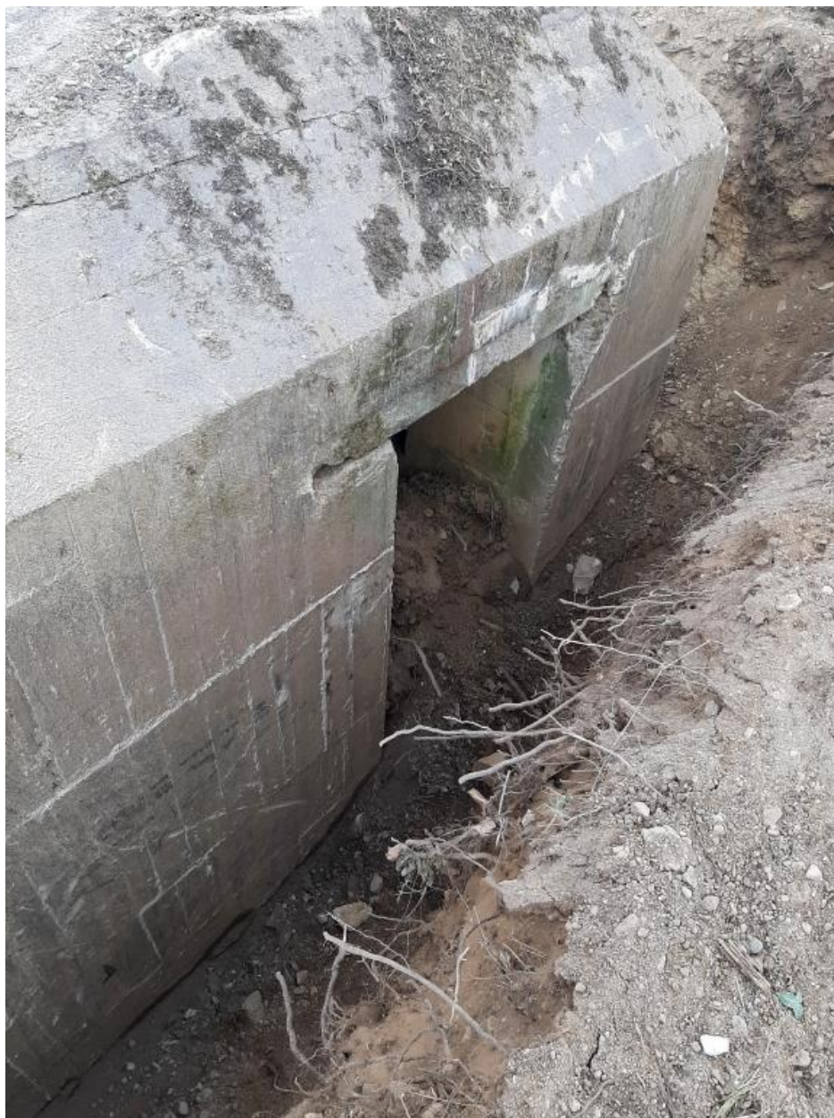
Vue de la déconstruction : entrée ouest (25 septembre 2022)
