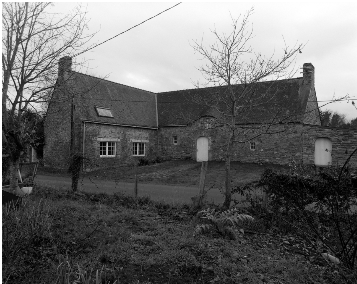
Vue générale est.
