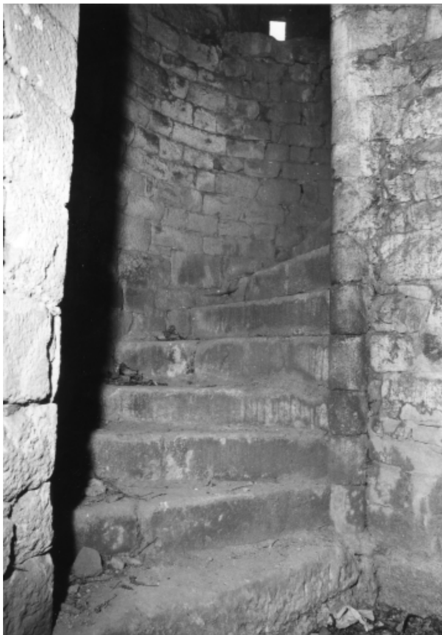
Ancien logis, tour d'escalier sud-ouest : départ de l'escalier.
